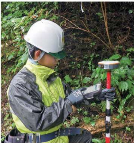
現場で測量作業
