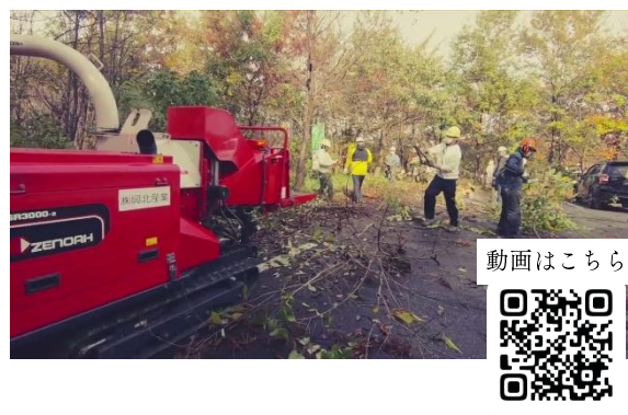
【R4.12.15公開 大和ハウス富山支店の森づくり】
